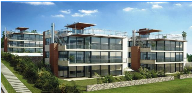
Condominio en Altura Casas del Mar, de la empresa Terramar, en Punta del Este, Uruguay.
